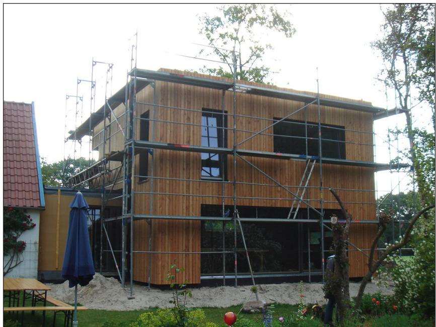
Der ursprünglich angestrebte Passivhausstandard war aufgrund der kleinen Gebäudekubatur nicht in einem wirtschaftlich zu vertretenden Aufwand zu erreichen. Durch entsprechende Dämmstärken konnte ein KfW40-Standard erreicht werden, der aber gemessen am Aufwand schon sehr nahe an der Grenze der Wirtschaftlichkeit liegt.
